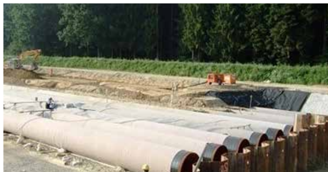
Verlegung eines Röhrenspeichers für Erdgas [1]
